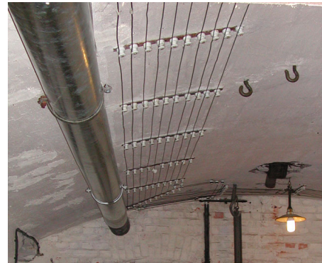
Mutzig, abri d'infanterie n°1(1899 – 1910) : réseau électrique et ventilation
