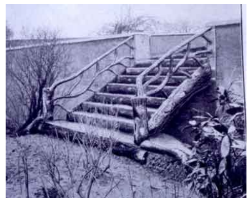
Rampes en béton moulé, parc des Buttes Chaumont, Paris (Milieu XIX e siècle)
